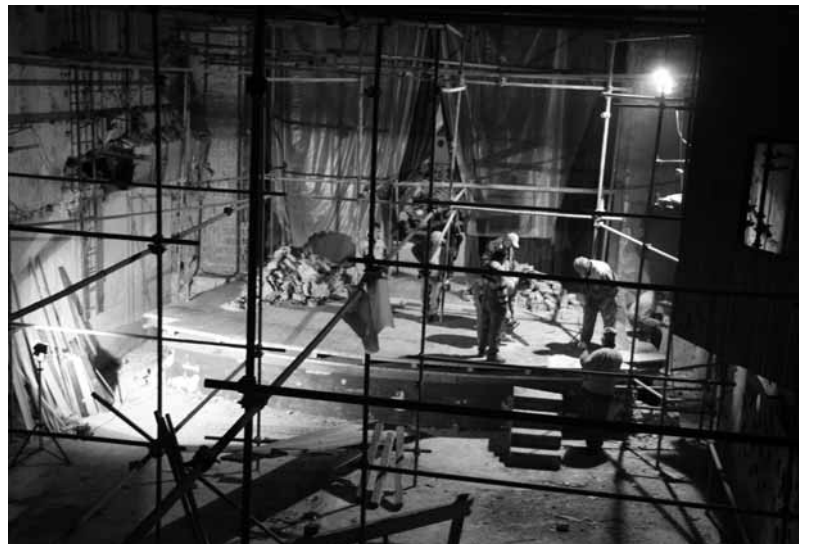
Šabačko pozorište - radovi
